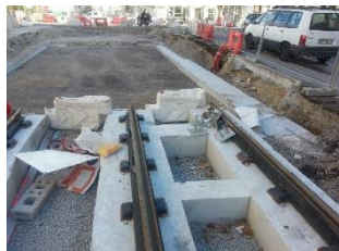
Rails & plots béton sur radier Nice décembre 2017
